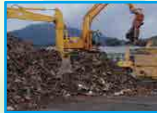
震災がれき・廃棄物の処理
