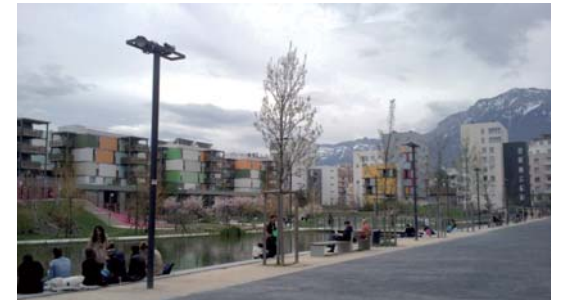
フランスの環境配慮街区・エコカルティエの事例(グルノーブル) 筆者撮影
