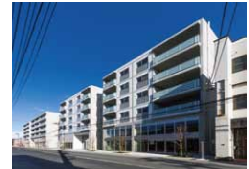
石巻市中央3丁目1番地区復興住宅竣工
