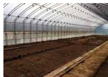
■中国天津市におけるフルスケールの土壌微生物を活用した下水処理システム
