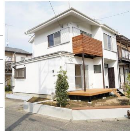
リノベーション後の外観
