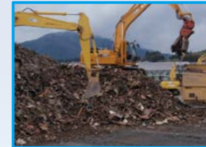
震災がれき・廃棄物の処理
